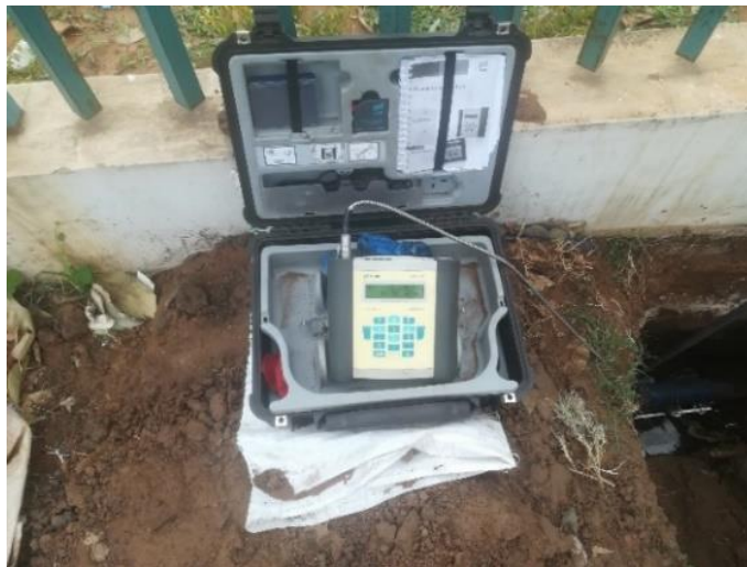
Figura 9: Fluxos 601 durante o processo de medição de caudal nos trechos na rede do BAIRRO 13 – Cidade de Xai-Xai
