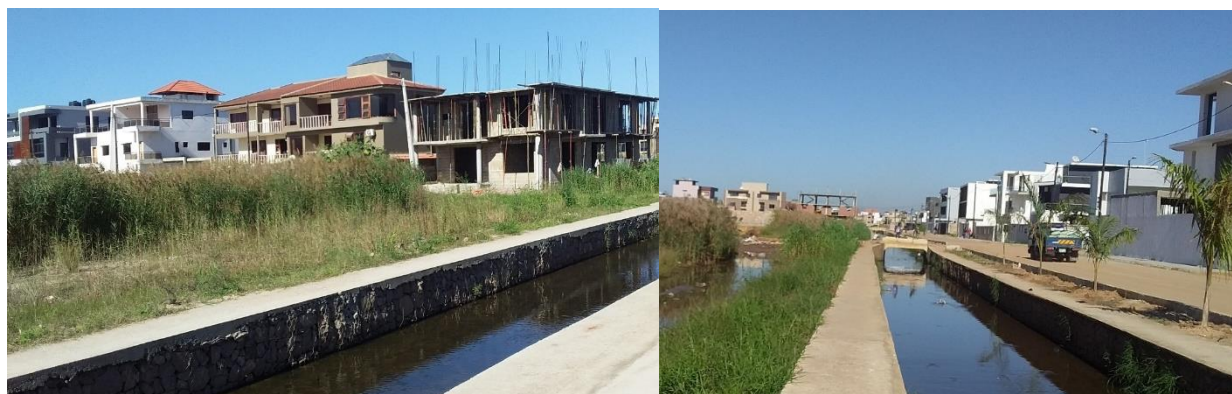
Figura 22: Valas de drenagens da área ordenada - foto da autoria dessa dissertação
