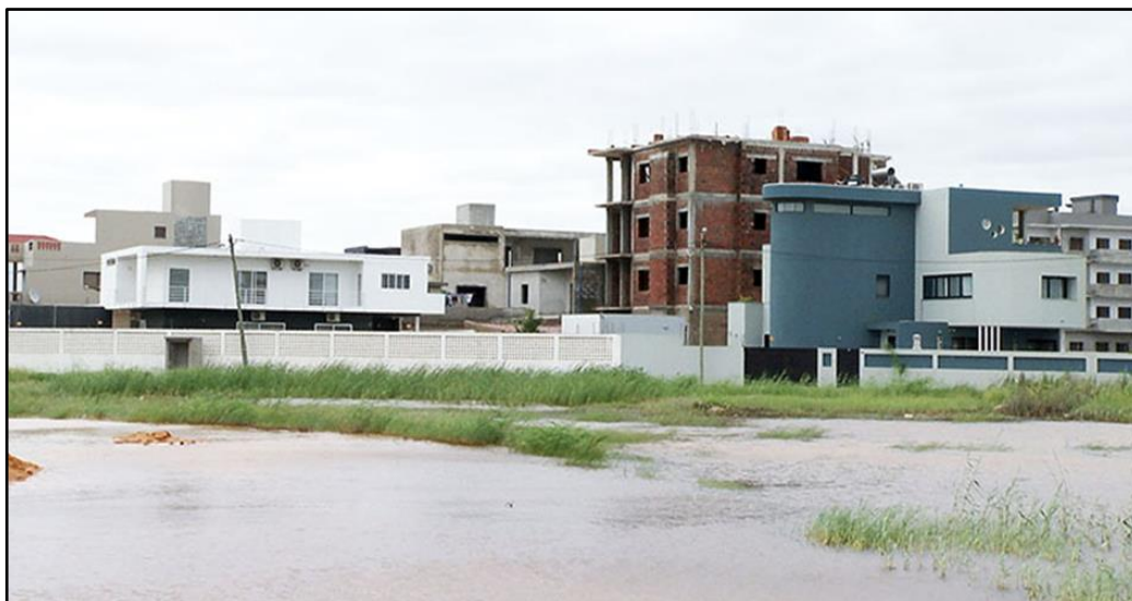
Figura 23: Inundação em zonas nobre - costa do sol
