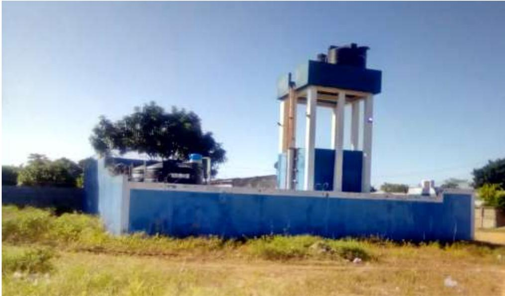
Sistema de abastecimento de água paralizado devido ao furto das respectivas bombas .
