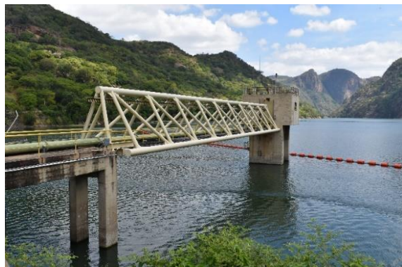
Figura 8: Torre e passadiço da captação de água
