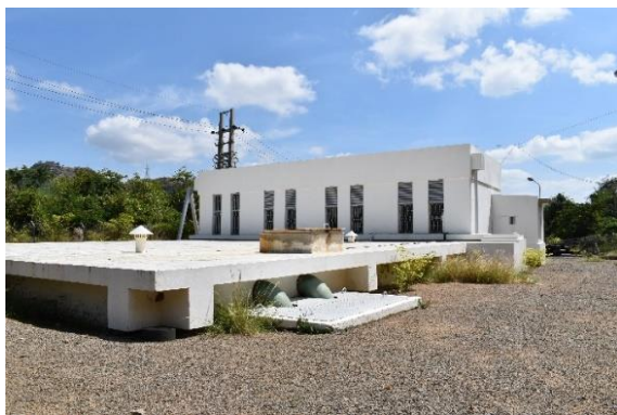
Figura 13: Vista da EET2
