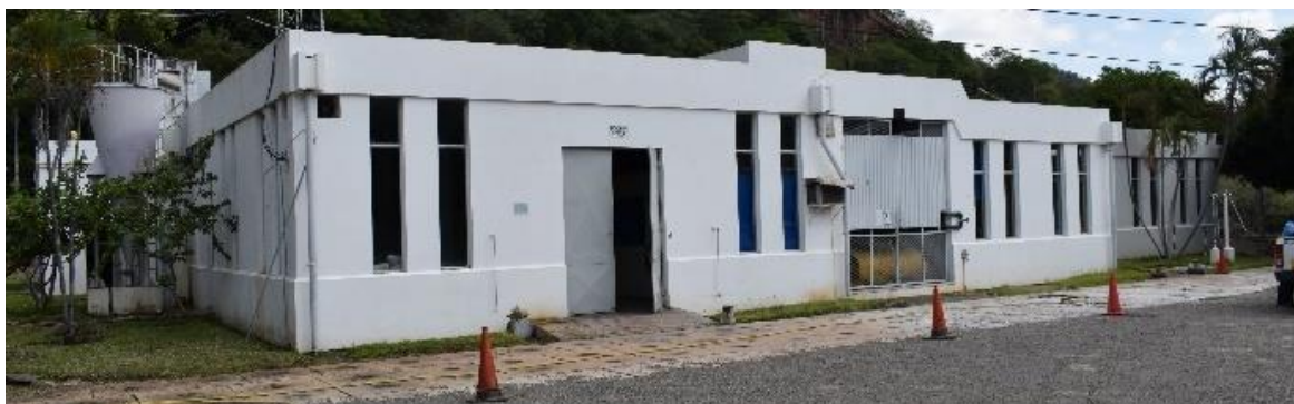
Figura 10: Vista frontal da ETA
