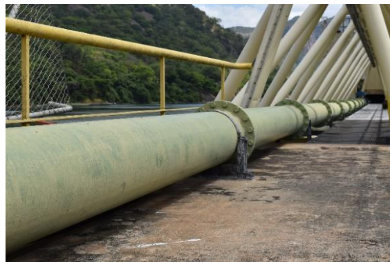
Figura 9: Adutora de água bruta
