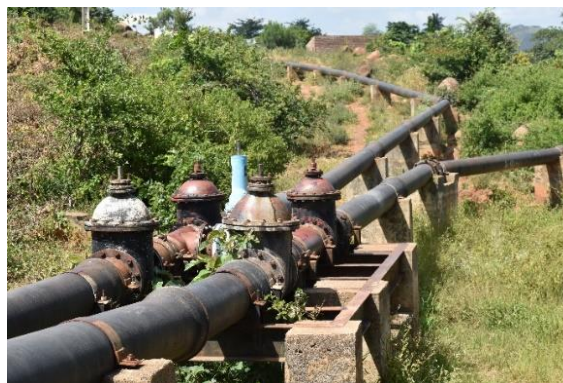
Figura 14: Adutora para o CD Norte (esquerda) e CD Sul (direita)
